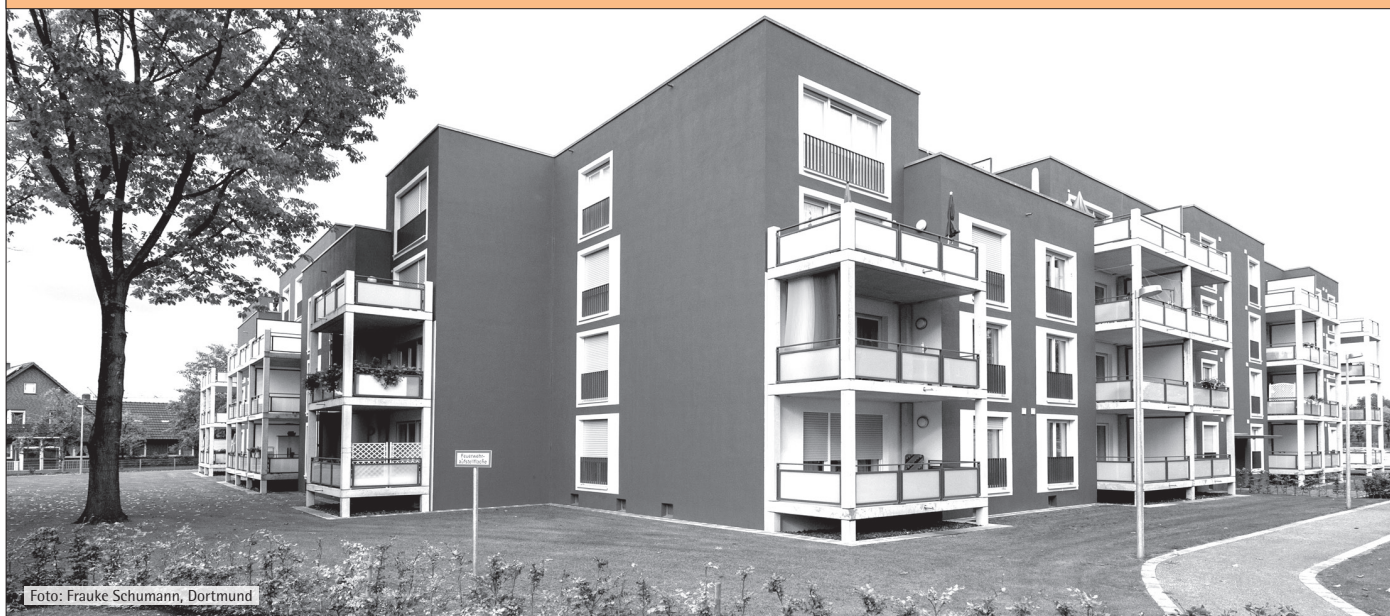
Abbildung 2: Bestandssiedlung Borken – die neu entstandene städtebauliche Strukturierung integriert sich in das kleinstädtisch geprägte Umfeld
