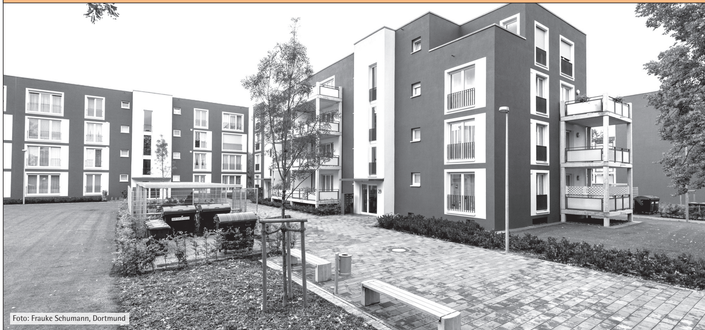
Abbildung 1: Rückbau und Erneuerung der Bestandssiedlung Breslauer Straße in Borken. Die Neustrukturierung der gemeinschaftlichen Freiflächen und eine komplett barrierefreie Gestaltung des Wohnumfeldes ermöglichen ein Nachbarschaftsleben für Jung und Alt
