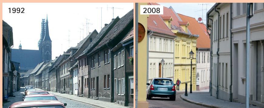
Abbildung 1: Köthen (Sachsen-Anhalt) vor und nach der Sanierung mit Städtebauförderungsmitteln
