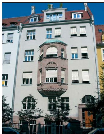
Das Gebäude der Umweltbank – ein Modellprojekt für ökologische Altbausanierung
