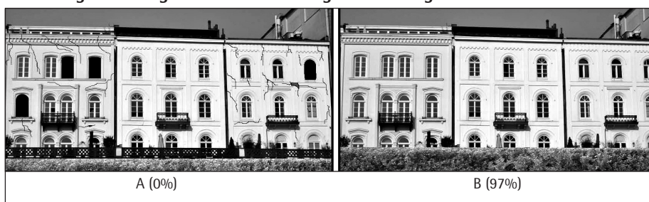
Abbildung 7: Homogenität der Bebauung – Sanierungsfälle
