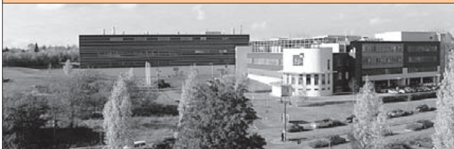
Abbildung 1: IHP-Institutsgebäude in Frankfurt (Oder)
