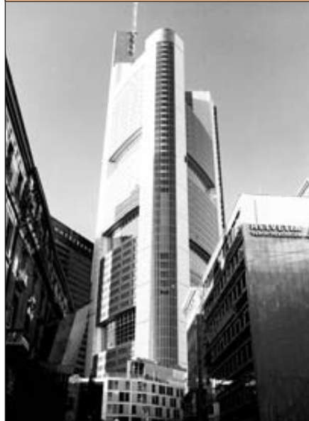
Abbildung 1: Commerzbank Tower Frankfurt am Main
