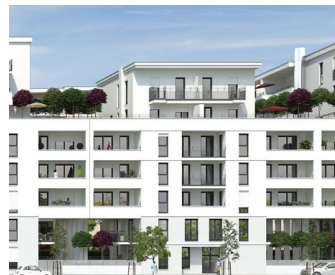
Wohnobjekt »Patio Verde«, Frankfurt am Main
