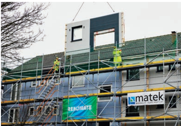
Montage einer seriell vorgefertigten Fassade in der Englischen Siedlung in Soest.
